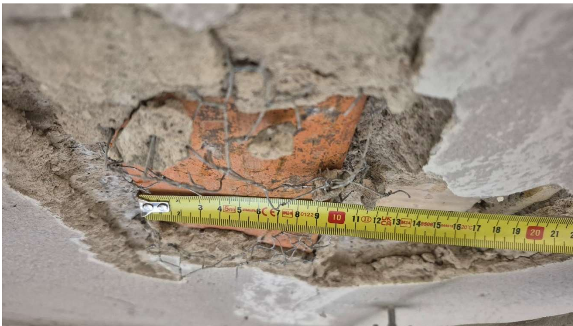
Fot.2 Widok odkrywki belki stropodachu.
