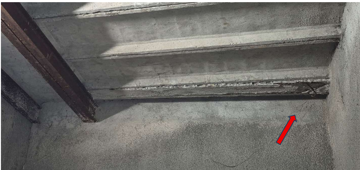
Fot.4 Widok stropodachu i odkrytych prętów stropodachu w pomieszczeniu nr 001.
