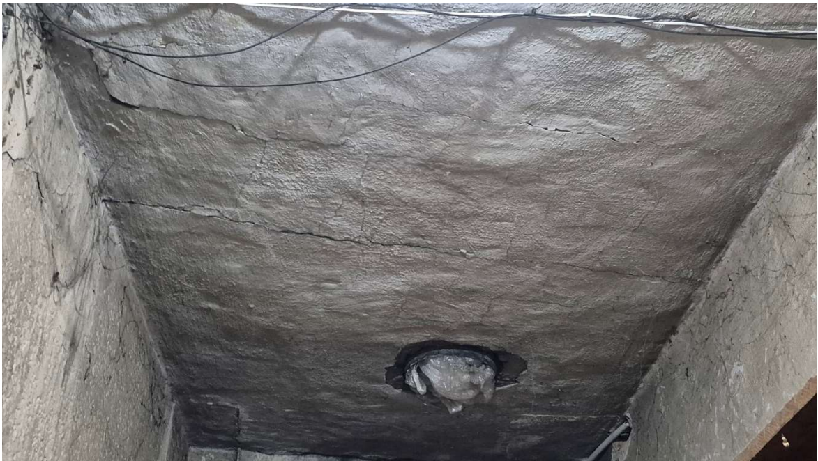
Fot.3 Widok zarysowań stropodachu w pomieszczeniu nr 004.
