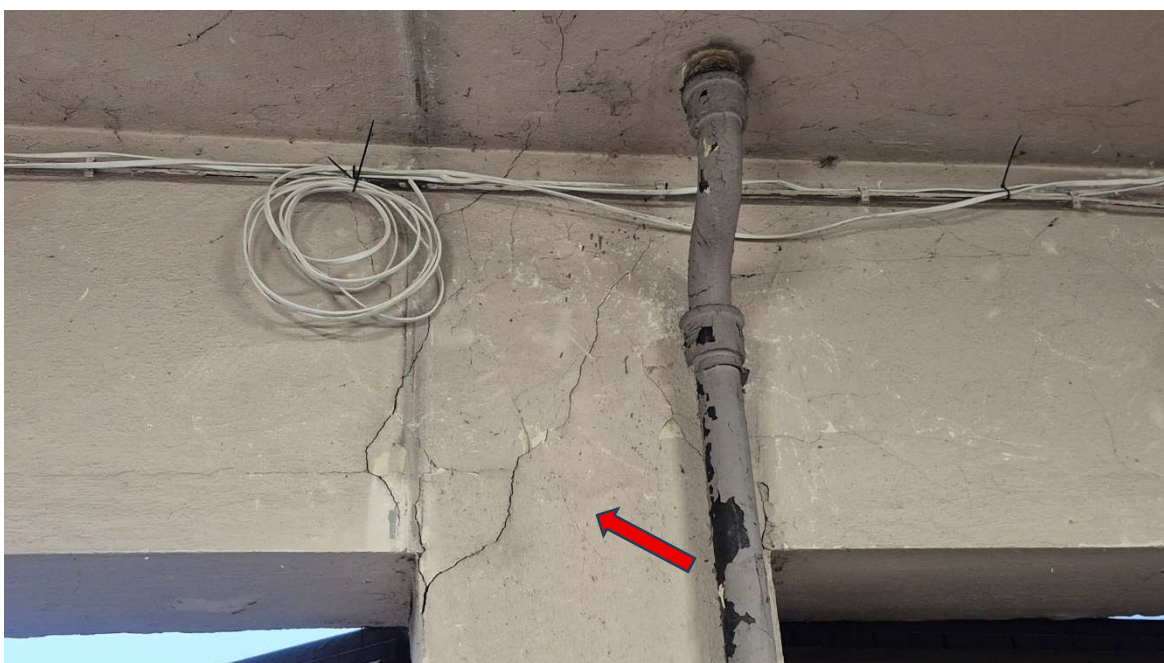
Fot.1 Widok zarysowań ściany nad filarkiem w strefie oparcia nadproża stalowego nad otworem bramowym.
